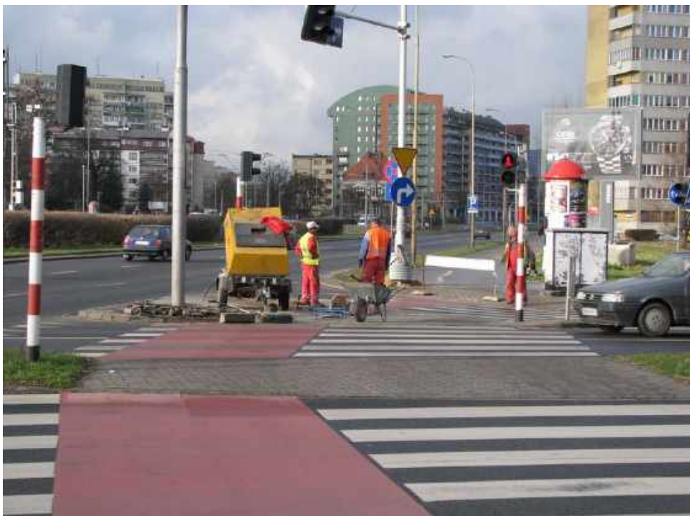
Akacja usuwania wystających krawężników na wrocławskich drogach rowerowych wymagała całkiem konkretnych robót drogowych
