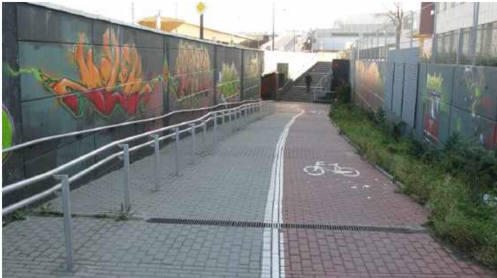
Zjazd (rampa) do tunelu bagażowo-rowerowego pod Dworcem Głównym
