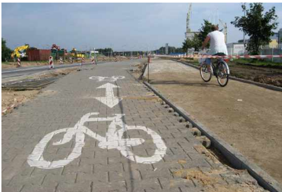
Ul. Szeligowskiego w trakcie przebudowy. Z lewej dotychczasowa droga dla rowerów i pieszych z kostki. Z prawej powstająca wydzielona droga rowerowa
