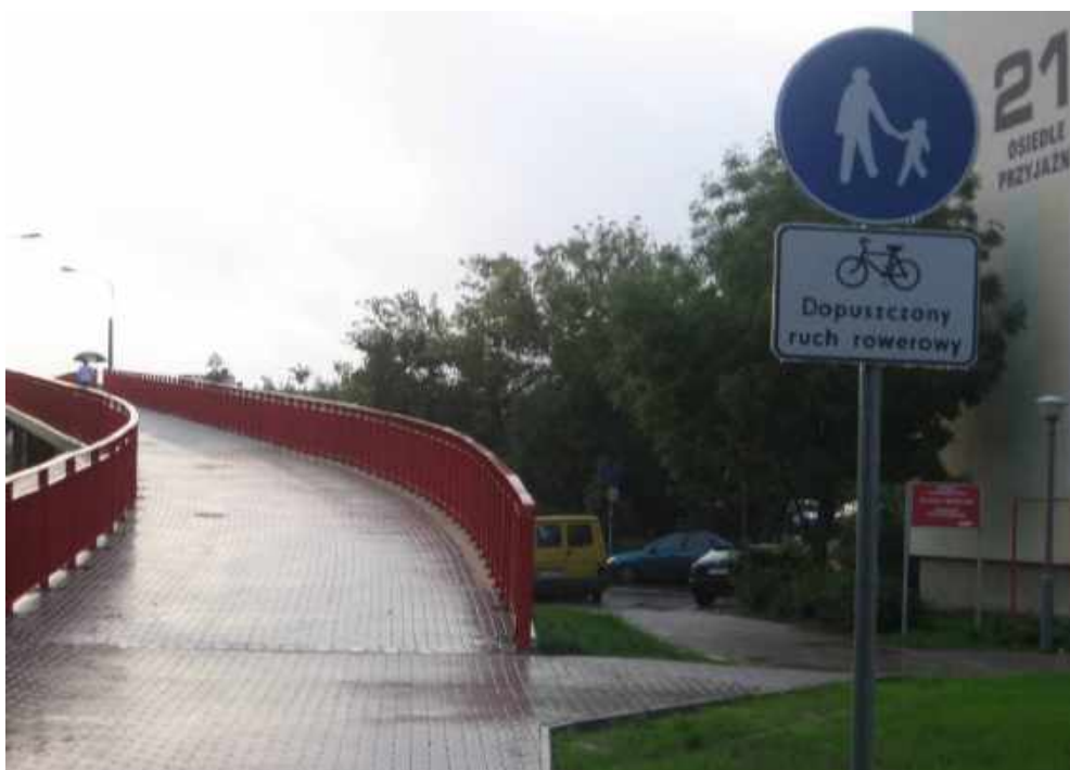
Nowe oznakowanie kładki nad ul. Mieszka I
