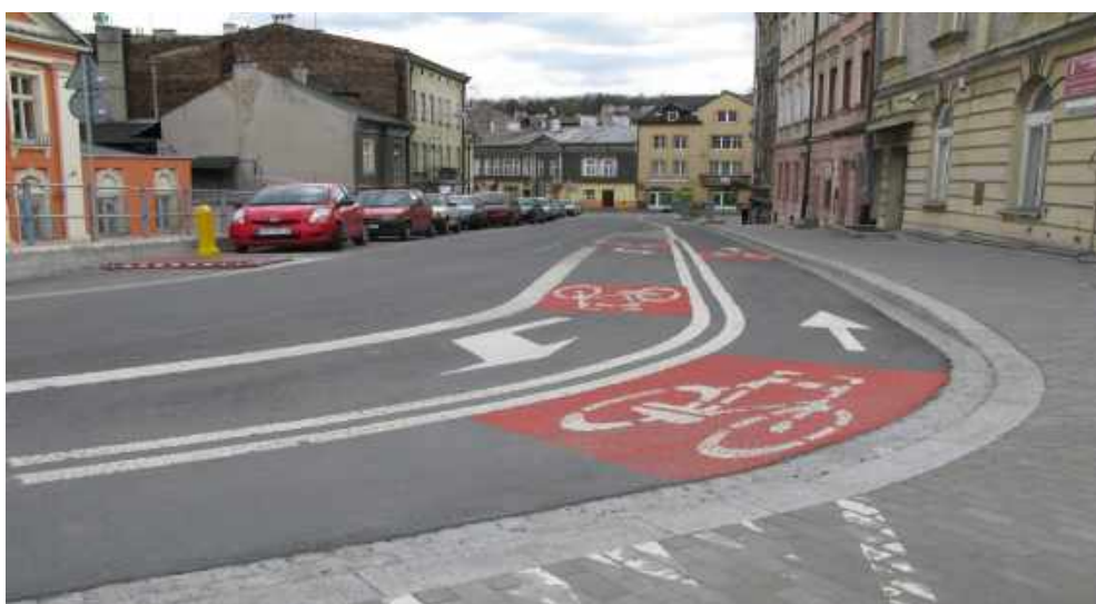
Ul. Brodzińskiego (widok od strony Kładki). Na zdjęciu widoczne pasy rowerowe: kontrapas rowerowy w kierunku ulicy Limanowskiego. W przeciwnym kierunku krótki fragment pasa rowerowego prowadzi jako pas lewoskrętny na Kładkę
