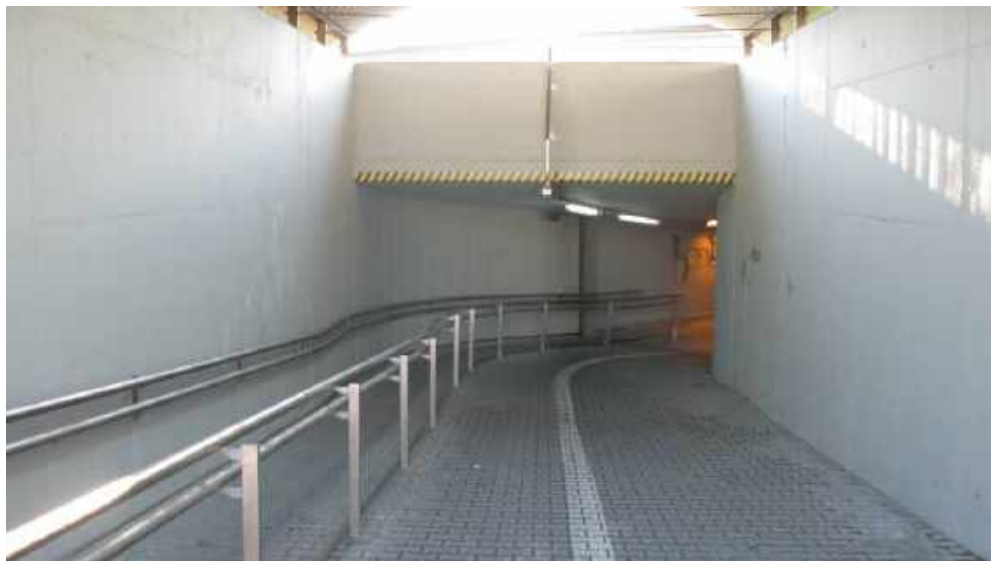
Widok wyjazdu/wyjścia z tunelu bagażowo-rowerowego w kierunku wschodnim (w kierunku ulicy W. Stwosza). Na zdjęciu łuk z ograniczoną widocznością osób i rowerzystów jadących z przeciwnego kierunku
