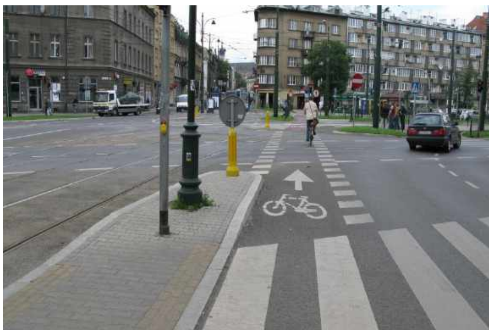
Ul. Starowiślna. Pas rowerowy na skrzyżowaniu z ul. Dietla – w kierunku Plant i Rynku Głównego. Pas rowerowy umożliwia jazdę na wprost przez skrzyżowanie z ulicą Dietla
