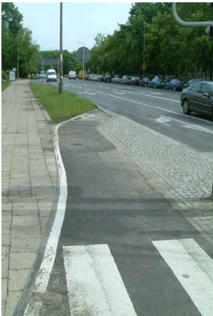
Łącznik umożliwiający wjazd na drogę rowerową przy ul. Bukowskiej z jezdni ul. Szpitalnej
