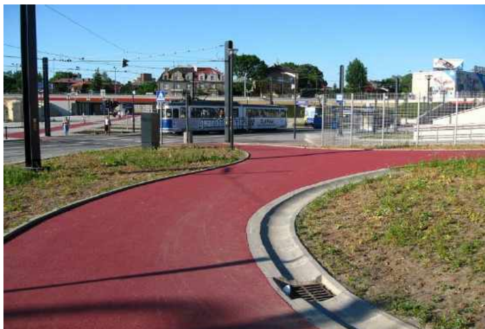
Rondo Mogilskie. Droga rowerowa w dolnym poziomie Ronda Mogilskiego, dostępnym tylko dla pieszych, rowerzystów i tramwajów
