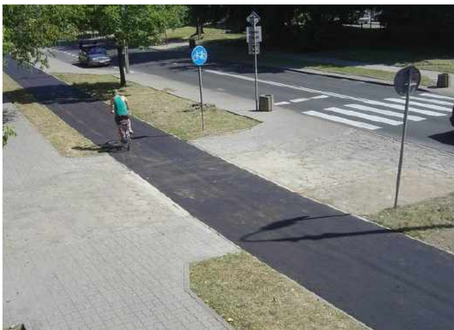
Zachowanie ciągłości ścieżki po realizacji (wymianie nawierzchni)
