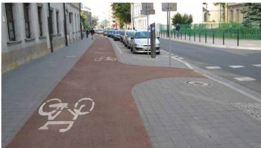
Na zdjęciu widoczny dobrze zaprojektowany i oznakowany wlot z ddr na ul. Warszawskiej w jednokierunkową ulicę Ogrodową
