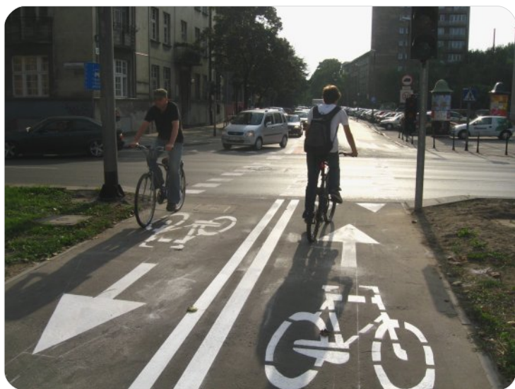
Kraków, skrzyżowanie al. Krasińskiego i ul. Dunin-Wąsowicza. Droga rowerowa stanowi czwarty wlot skrzyżowania i umożliwia przekroczenie al. Krasińskiego w miejscu niedostępnym dla ruchu samochodowego.
