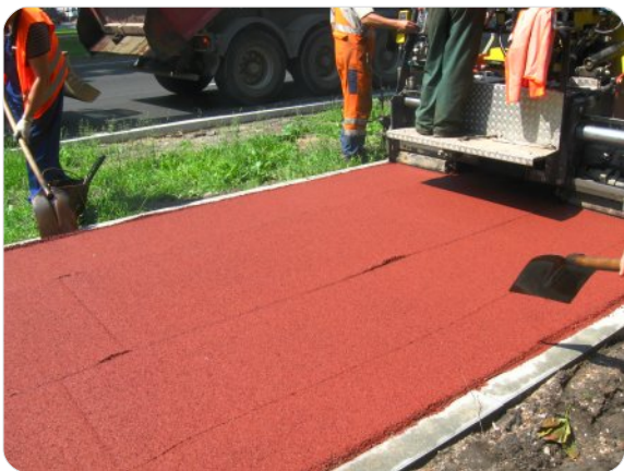
Gdańsk, al. Zwycięstwa. Podbudowa drogi rowerowej z kruszywa dogęszczanego mechanicznie (wałowanego) i stabilizowanego chudym betonem. Widoczne uszczelnione masą bitumiczną krawężniki zamykające konstrukcję.
